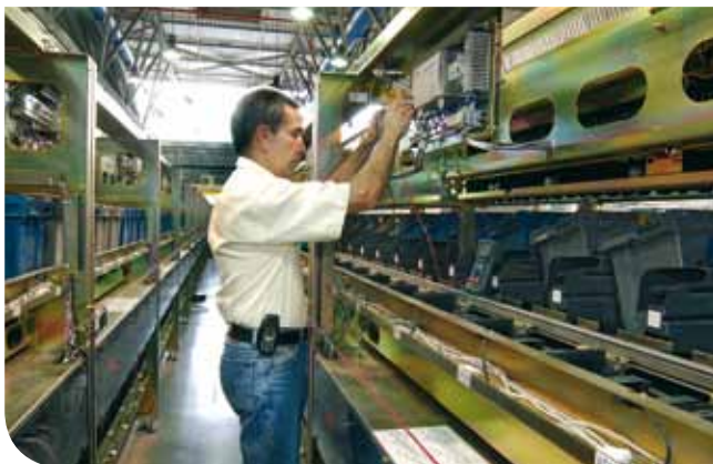
Couloir de maintenance
